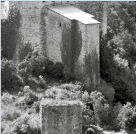
Capella del Sant Crist. Cara Nord. En primer terme la Torre Petita.
